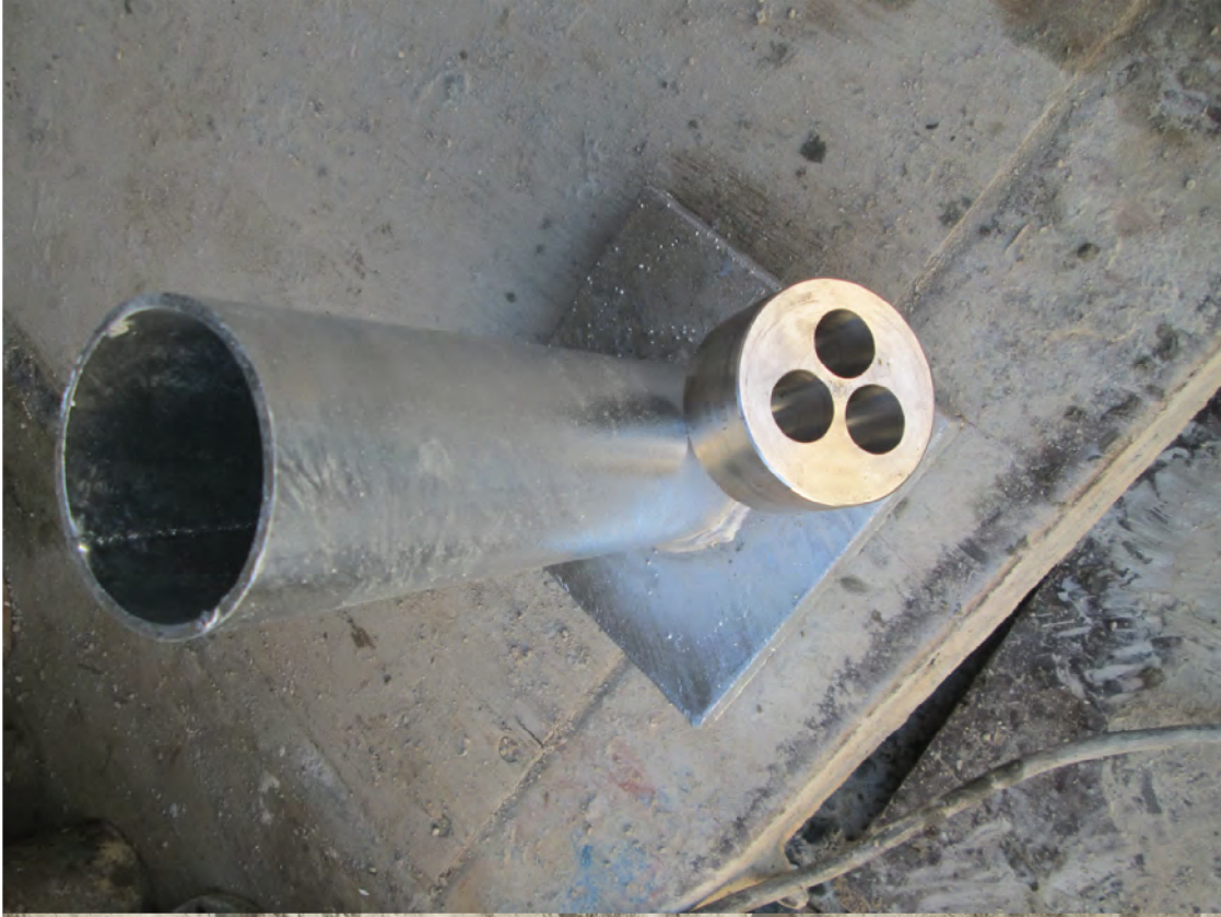
17-Trompet ve kafanın kiriş yerleştirilmesi
