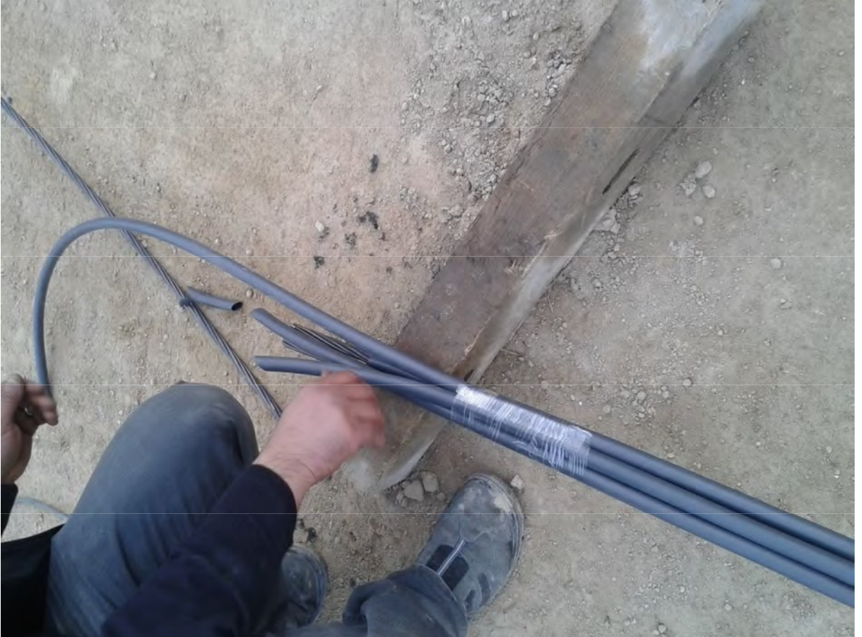
6-Serbest kısımdaki enjeksiyon pimaşının görünümü dışarıyı dolduracak olan daha uzun
