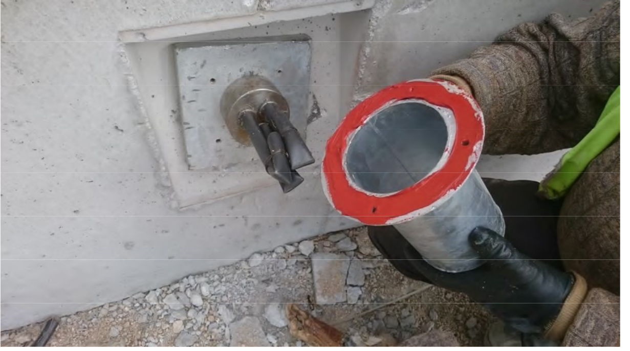
20-Koruma kapađına sıvı conta sürülerek kapađın plakaya takılması
