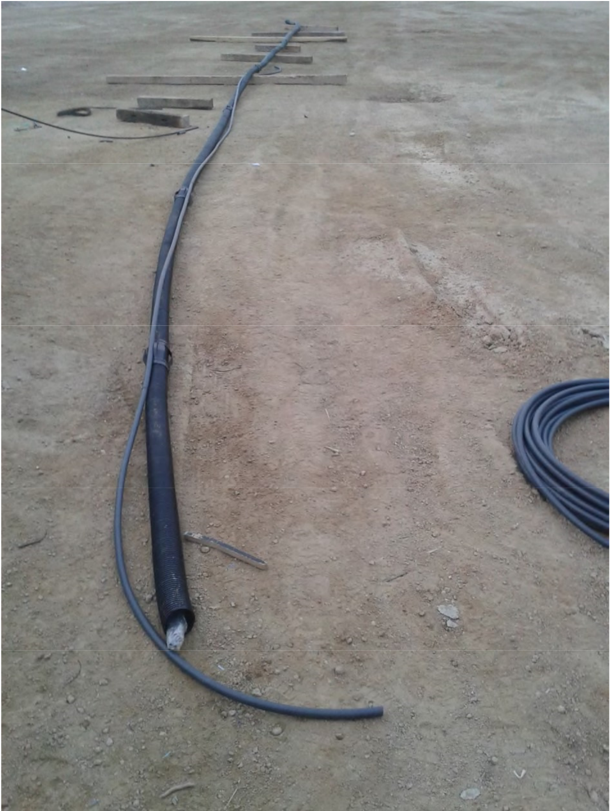
11-20x6 patlatma enjeksiyon pimaşının takılması
