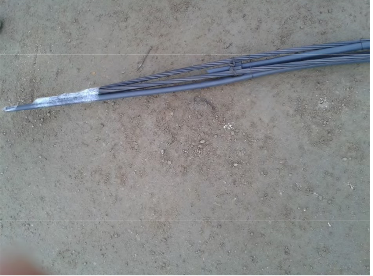
5-kök bölgesindeki kısa ve uzun olan 20x6 enjeksiyon pimaşı montajı
