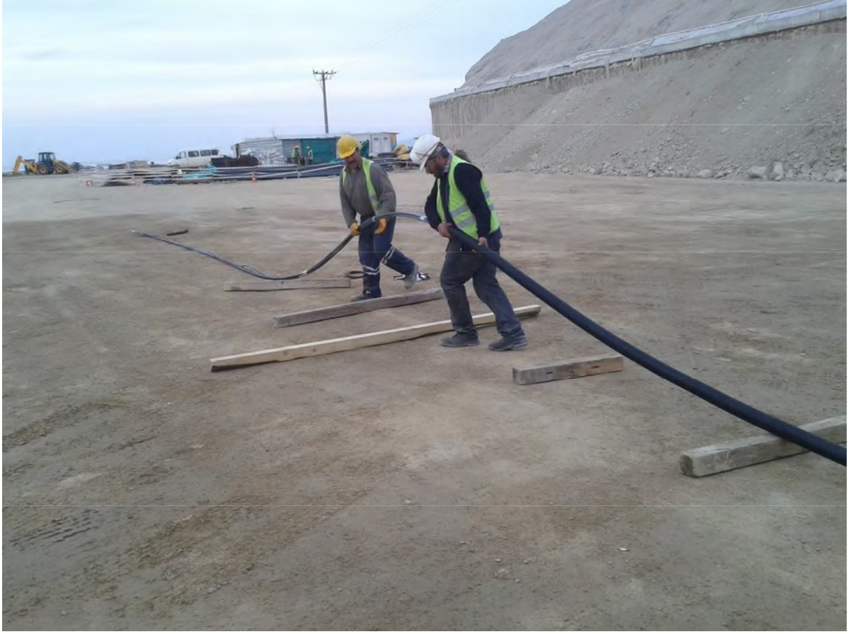
7-Koruge borunun geirilmesi
