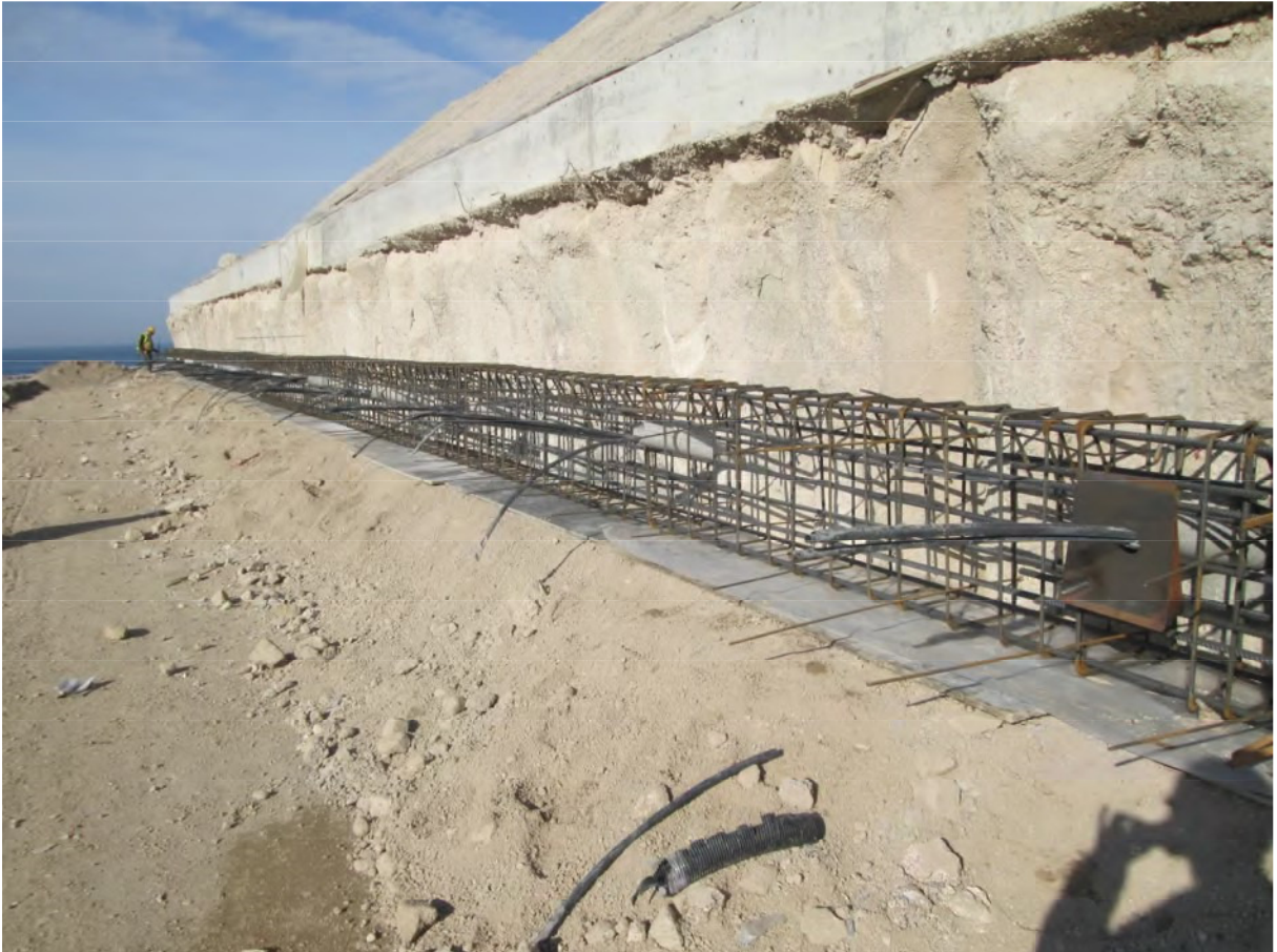
15-Kuşak kirişi demir donatısının bağlanması
