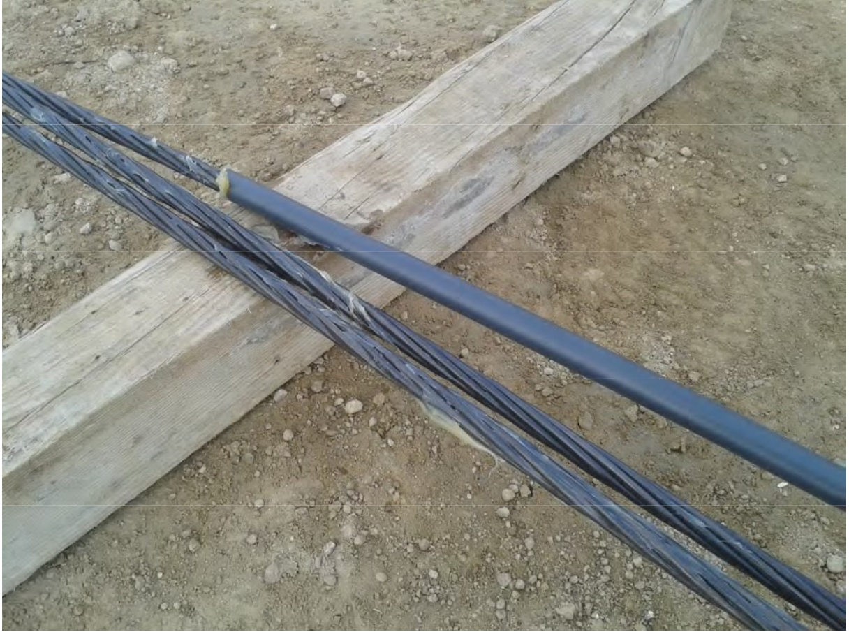
3-serbest kısımdaki halatların ayrı ayrı gresslenerek 20x4 pimaş ile montajı
