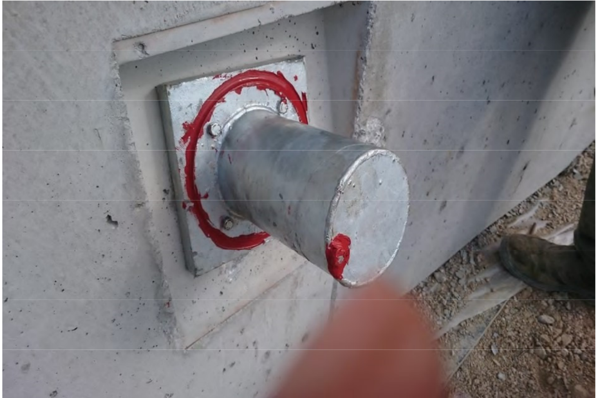
21-Kapađın takılmasının ardından cıvatalarının sıkılması ve etrafının sıvı conta ile izalasyonu
