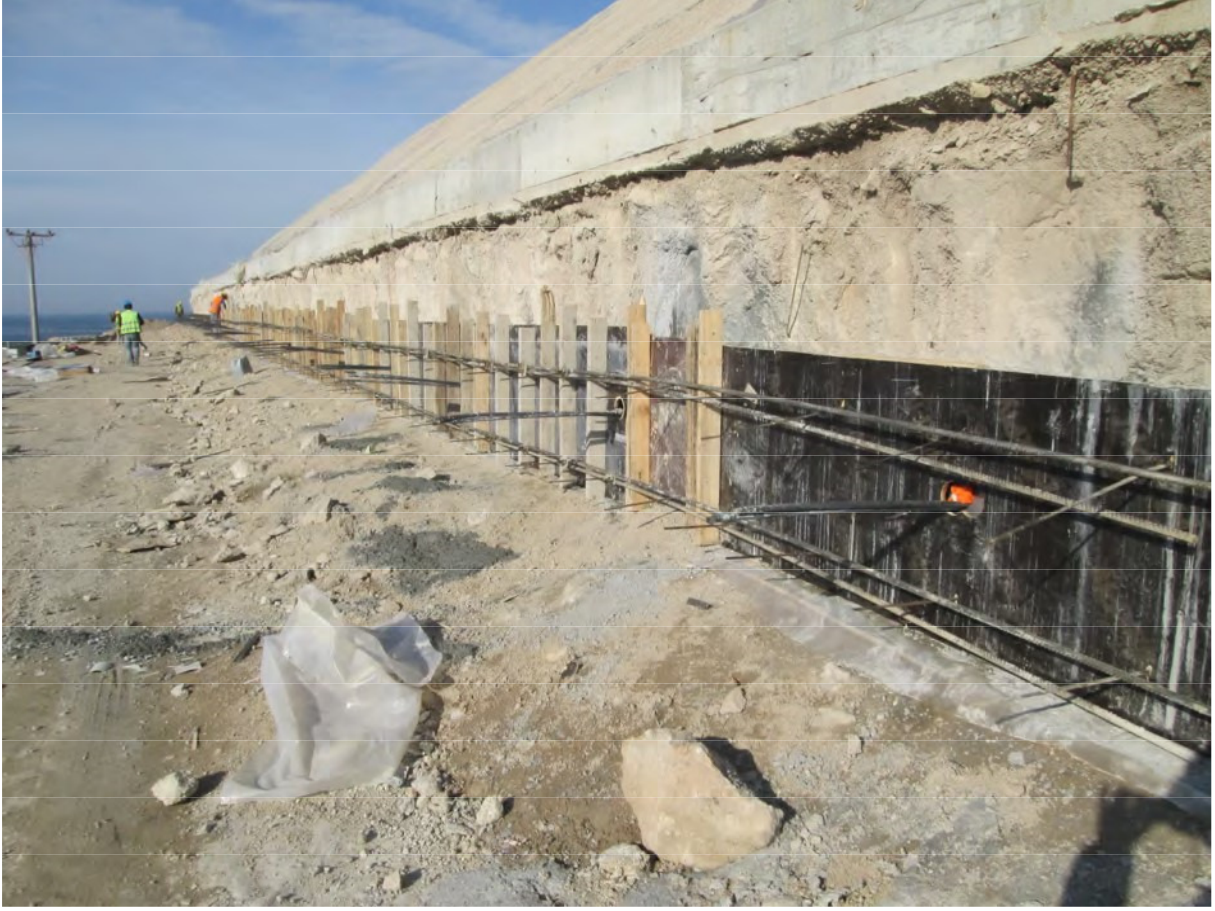
16-Kuřak kiriři kalıp kapatılması beton atılması
