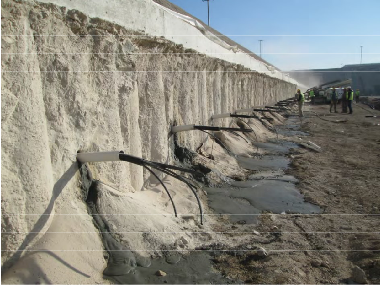
14-Pvc boru ile donatının açısına ve korumaya alınması
