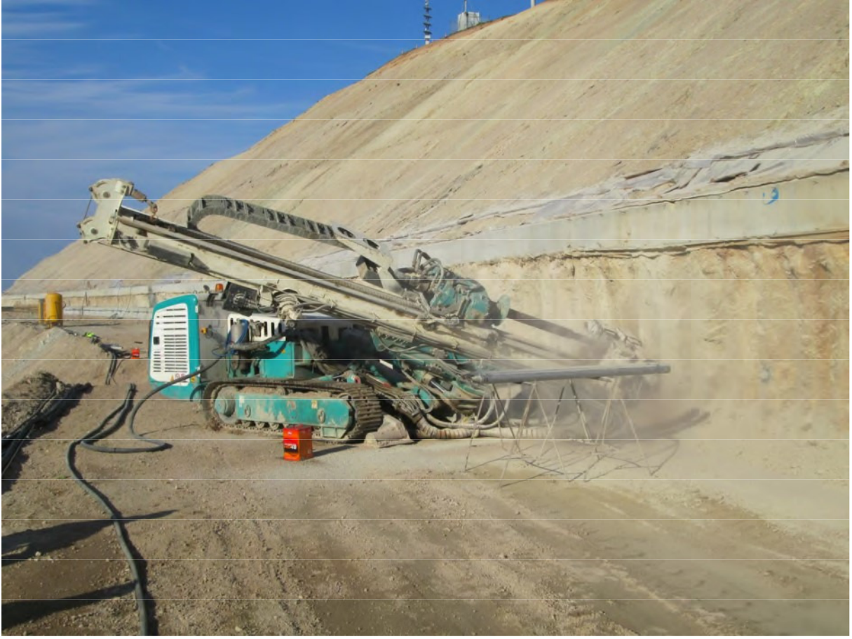
12-Projedeki açığa göre delgi işleminin yapılması
