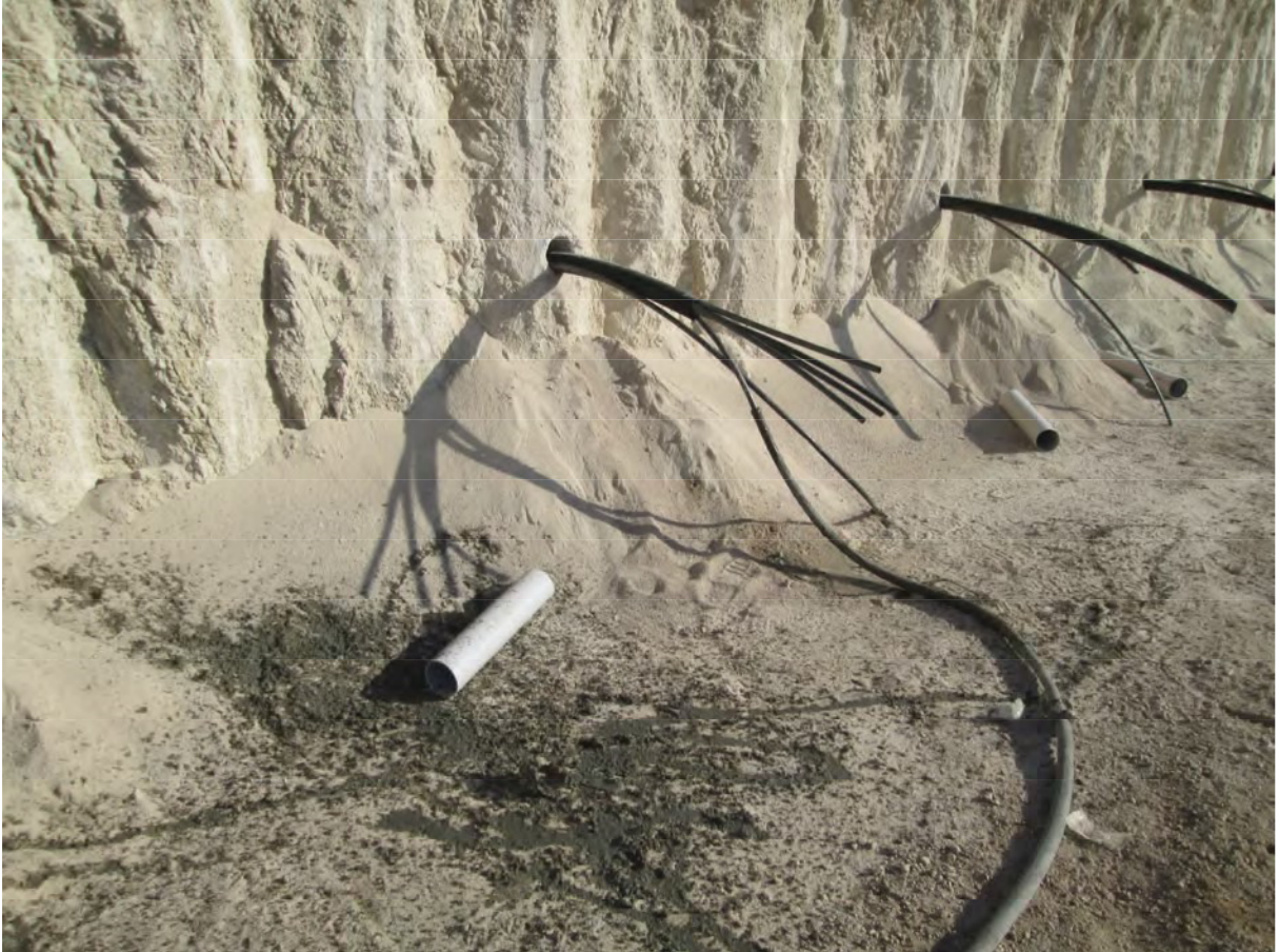
13-Halatın kuyuya yerleştirildikten sonraki enjeksiyon işlemi
