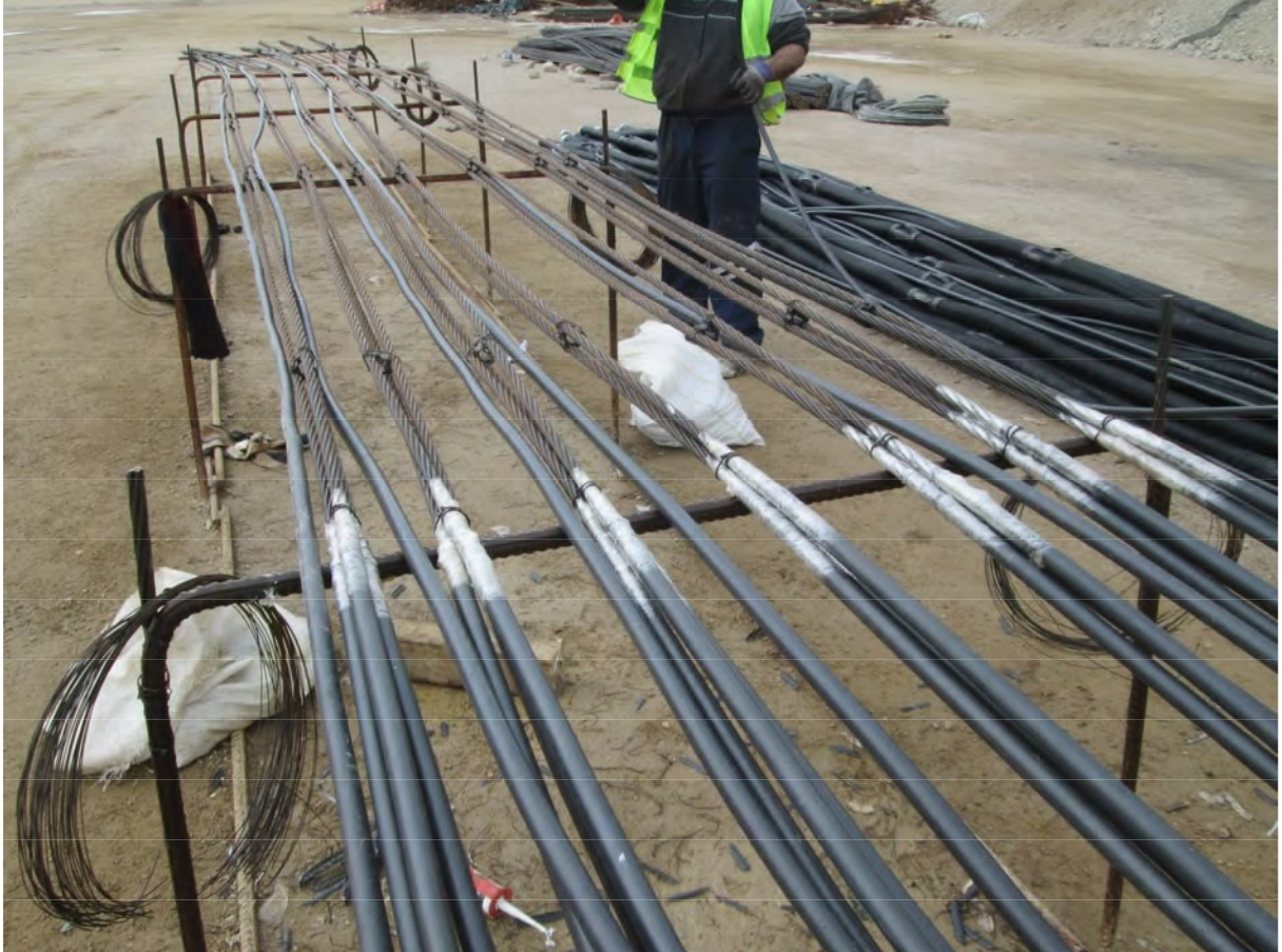
4-Serbest kısmın silikon ve bant ile izolasyon ve yalıtımı
