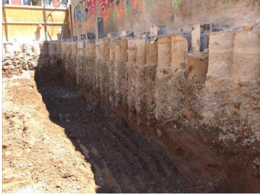
Resim. 1A.5. DSM Elemanları ile Duvar
