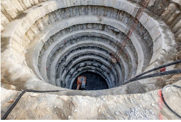
Resim 1A.19. Kesişen Kazıklı Duvar
