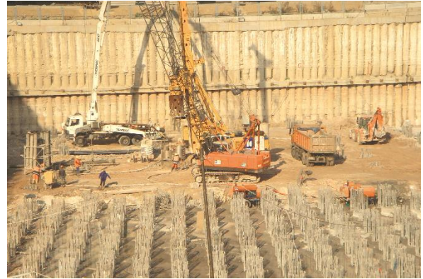
Resim 1A.18. Aralıklı Kazıklı Duvar
