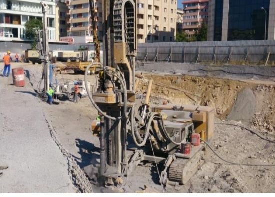
Resim 1A.15. Mini Kazık Makinesi
