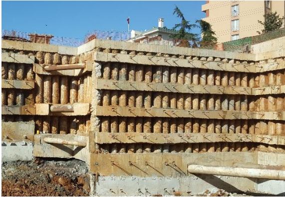
Resim 1A.17. Aralıklı Kazıklı Duvar
