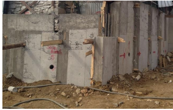
Resim 1A.12. Kuyu Perde Duvar
