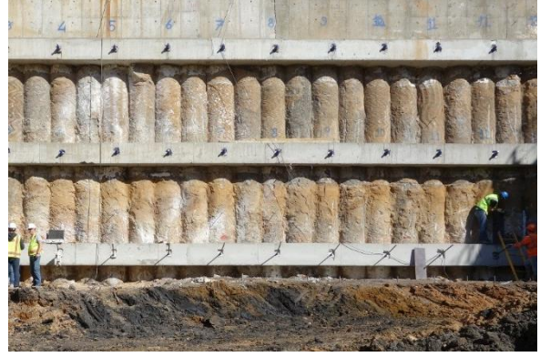
Resim 1A.20. Kesişen Kazıklı Duvar
