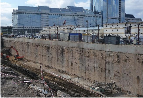
Resim 1A.21. Diyafram Duvar
