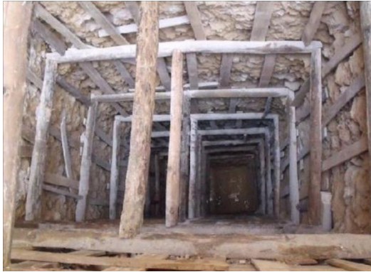
Resim 1A.11. Kuyu Geçici Ahşap Destek
