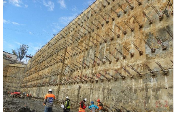
Resim 1A.22. Diyafram Duvar
