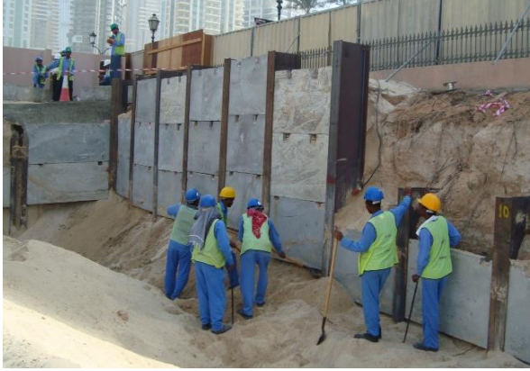
Resim 1A.3. Berlin Duvarı İmalatı
