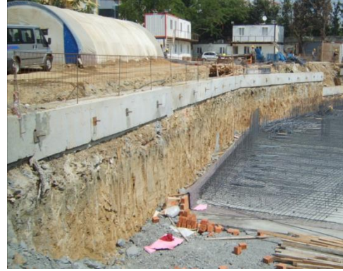
Resim. 1A.6. Jet Grout Elemanları ile Duvar
