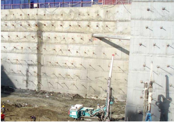
Resim 1A.7. Ankrajlı betonarme perde
