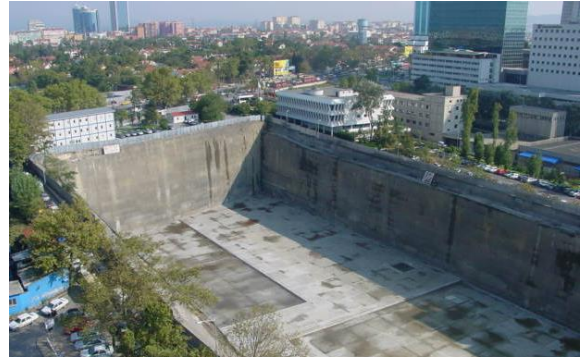
Resim 1A.14. Zemin Çivili Duvar
