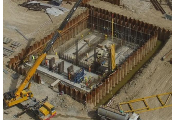
Resim 1A.2. Palplanş Uygulaması
