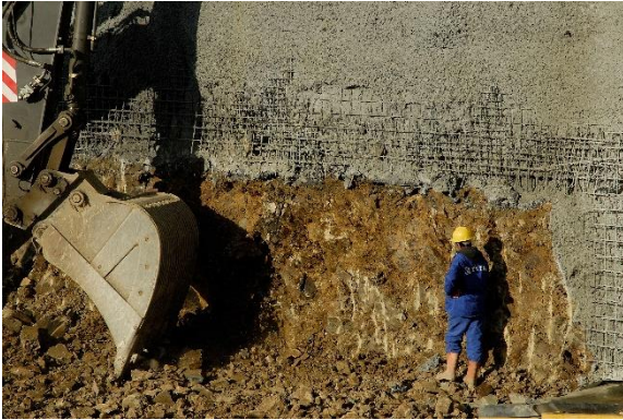
Resim 1A.13. Açılan Kazı Aynası
