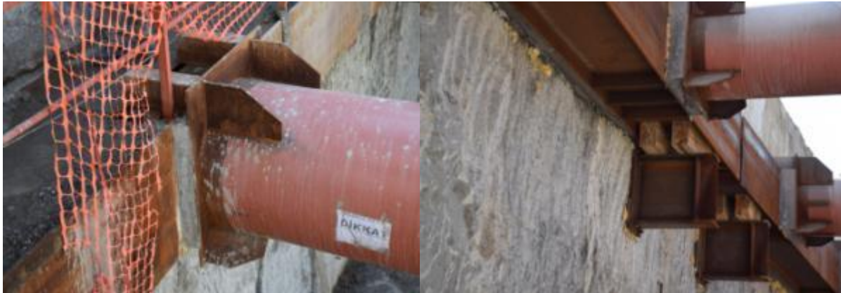
Resim 3.1. Tipik destek elemanı ve kuşak kirişi görünüşü
